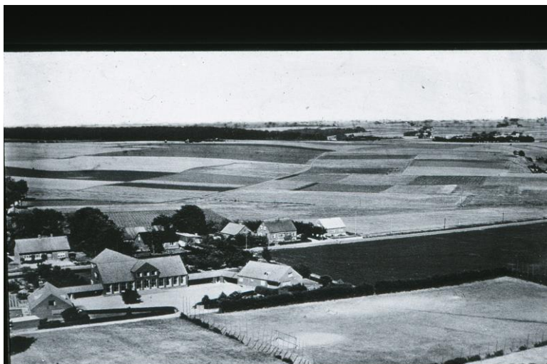
Korsholm skole fotograferet i 1946. Bebyggelsen Korsholm mangler fuldstændig. Længst til venstre anes Randersvej med vejtræer.
